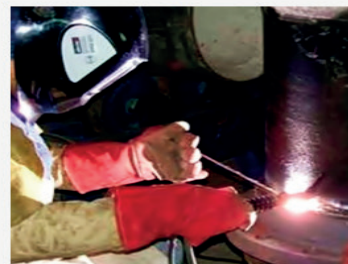
MECANIZADO DE PARTE MECÁNICAS Y SOLDADURA
